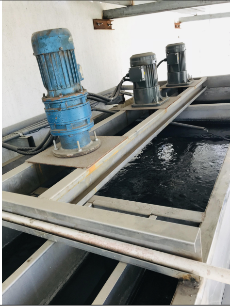
图 3-3 废水处理设施
