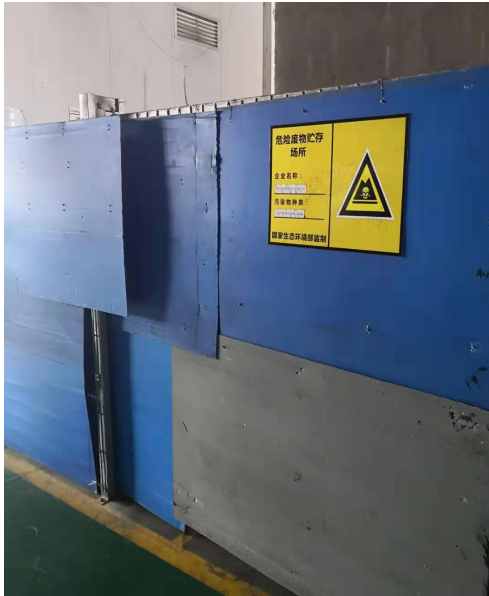
图 3-15 危废仓库外部
