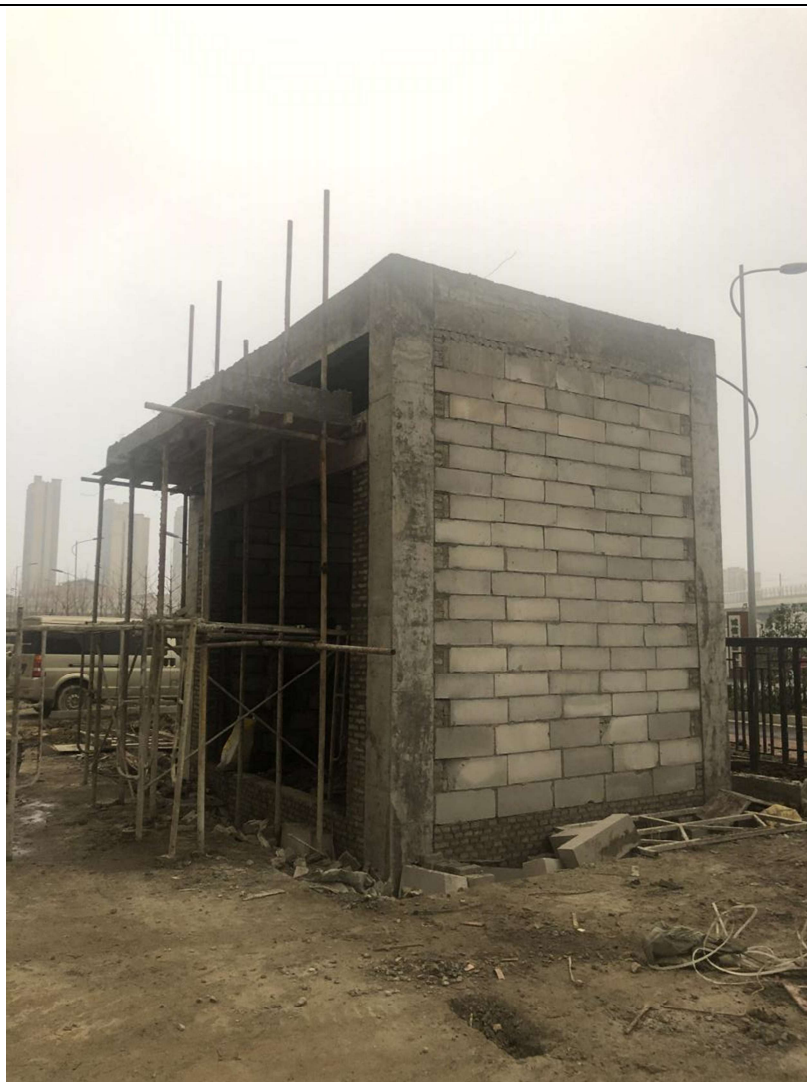
小区生活垃圾房
