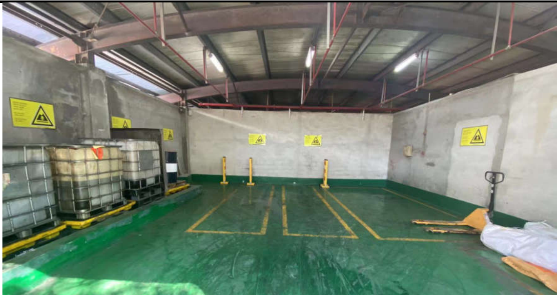
危废标识、地面防腐、内部摄像头
