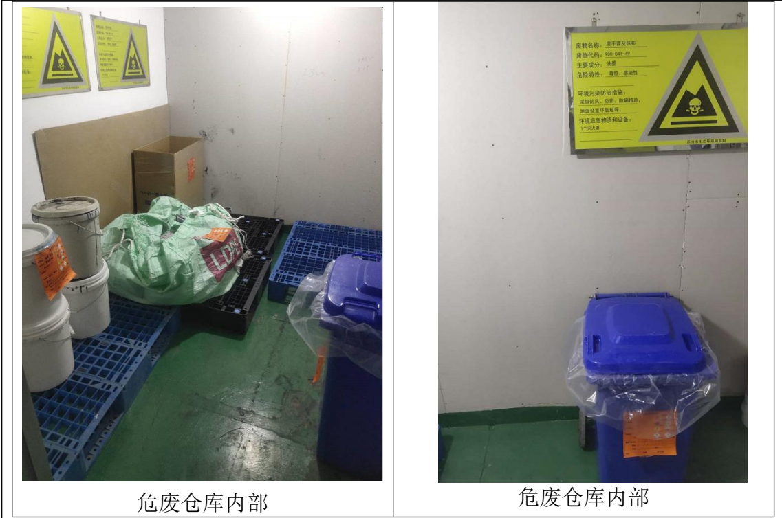
图3-8 危险废物贮存场所建设现状
