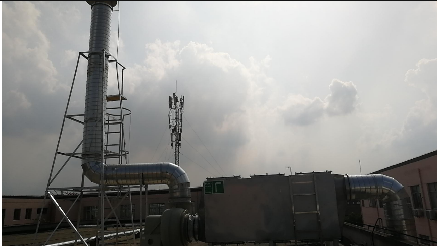
图 3-2 废气处理设施图
