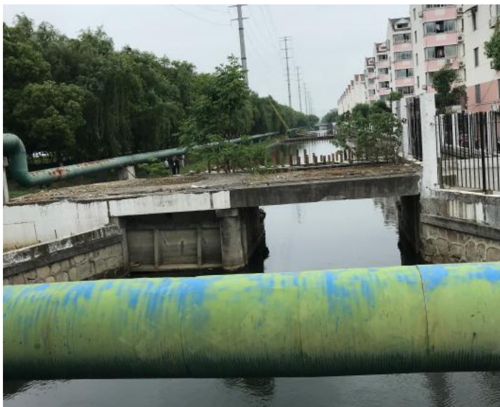
南闸站工程位置现状
