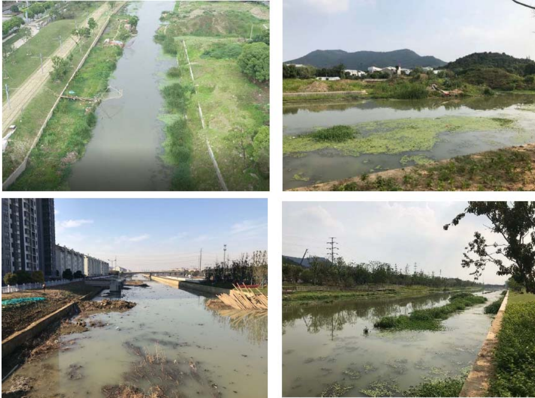
图 1-1 泇光运河河道淤积现状图
