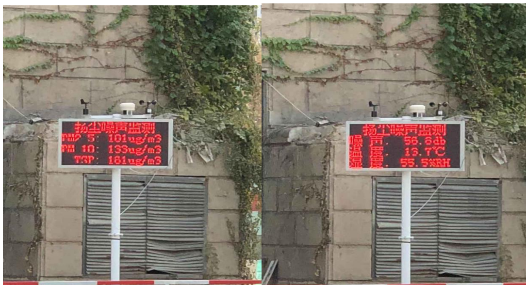
8、围墙上设置喷淋系统，确保施工范围内的扬尘抑制。
