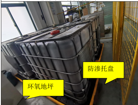
危废间防渗托盘、环氧地坪
