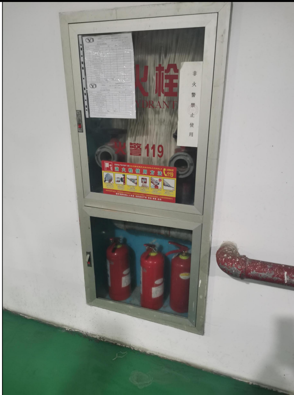
消防栓、灭火器
