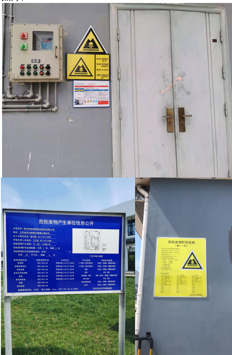
图 1 危废暂存区所外部照片
