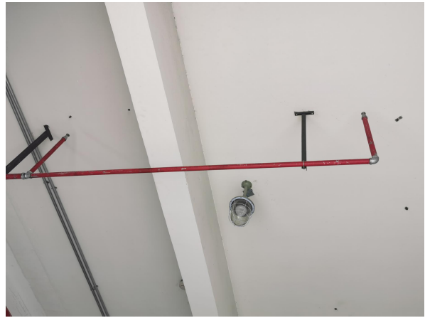
图 5 危废暂存区防爆灯照
