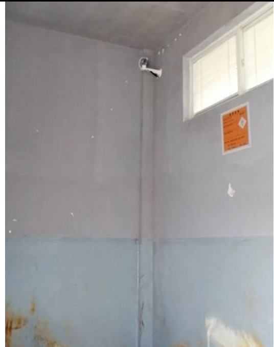
危废仓库内视频监控 1
