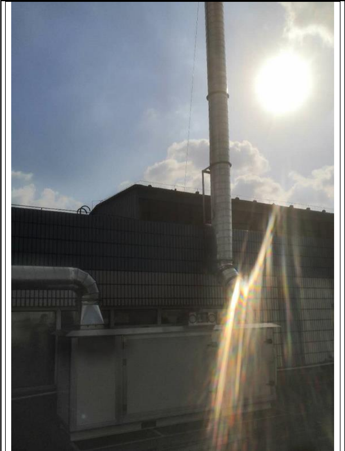
点胶废气治理设施及排气筒
