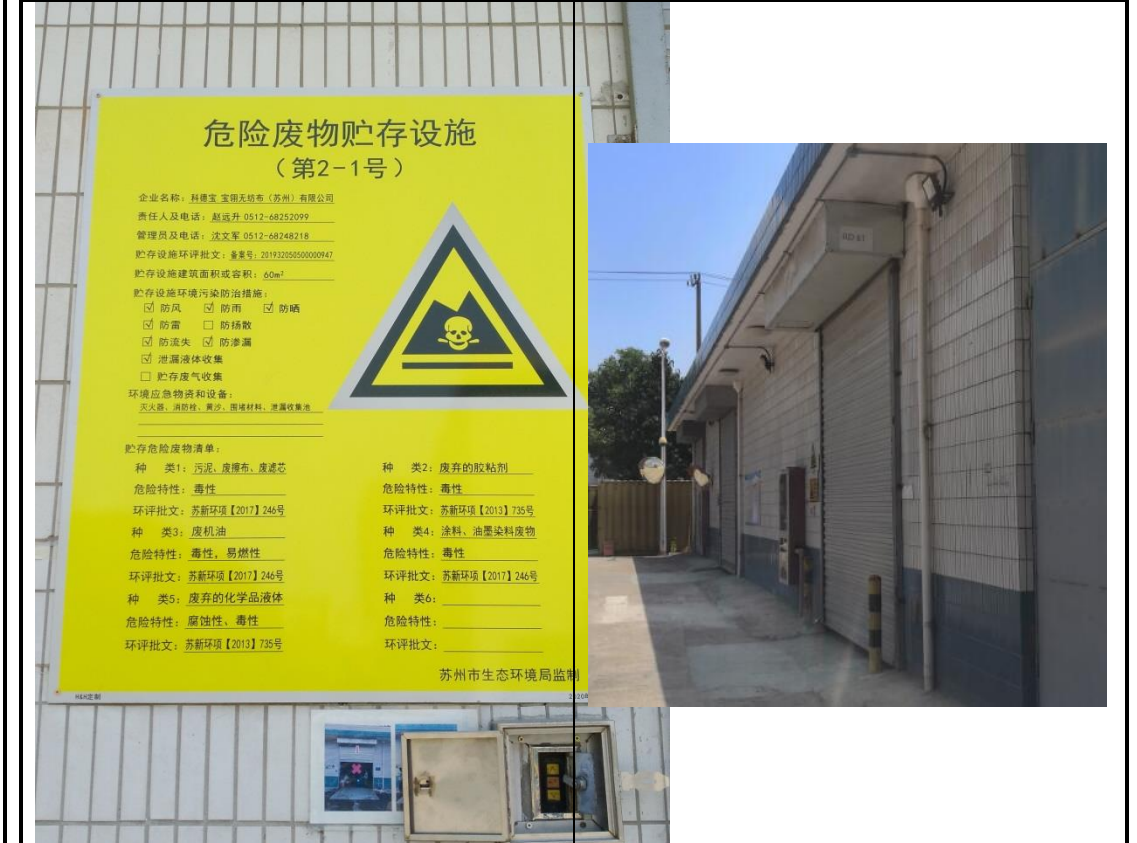
危废仓库外标志牌
