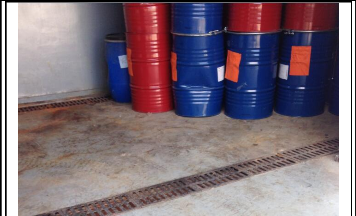
收集渠及环氧地面
