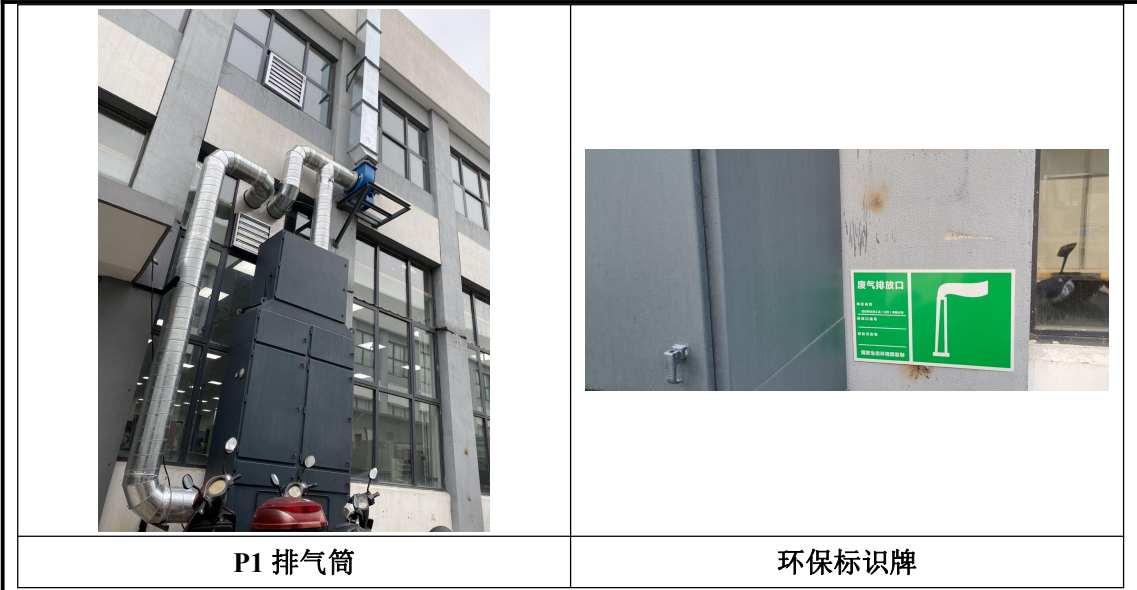
图 3-1 废气处理设施及排气筒
