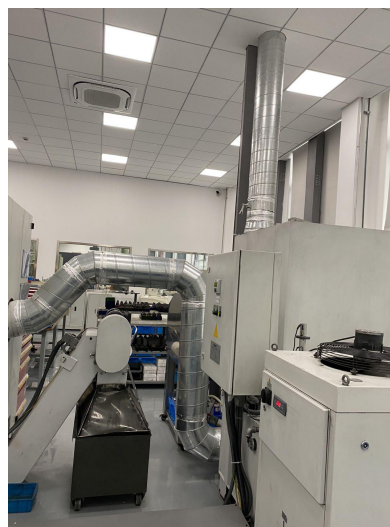
石墨加工中心废气收集管道
